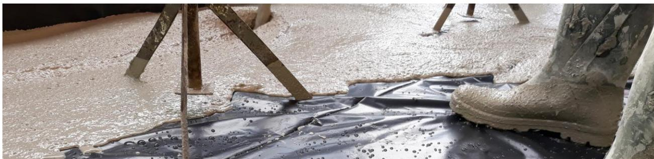
**Mortero autonivelante en base cemento, suministrado a pie de obra en camión hormigonera, diseñado para la utilización en recrecidos convencionales de interiores.**
